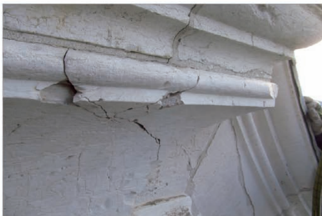
Porzione di basamento in fase di distacco
