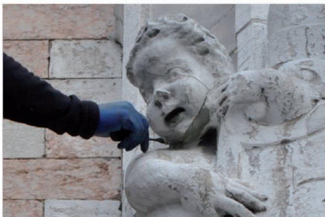
Operazione di sigillatura delle lesioni di maggiore entità
